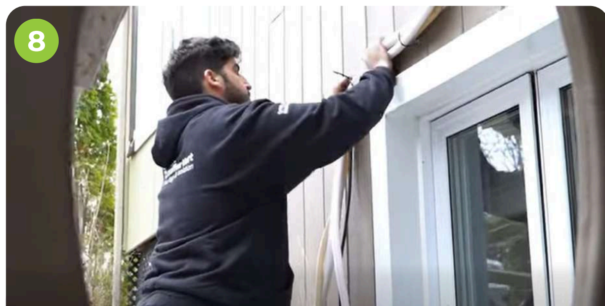
Relier les tuyaux réfrigérants de l'intérieur à l'extérieur
