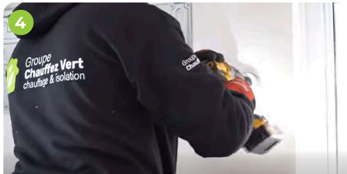
Préparation d'installation des tuyaux réfrigérants
