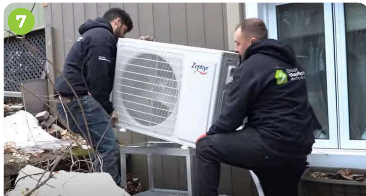
Installation du compresseur
